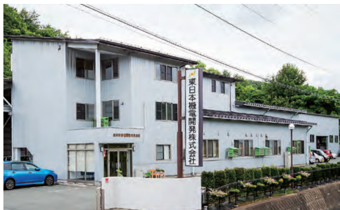
東日本機電開発(株)の社屋
